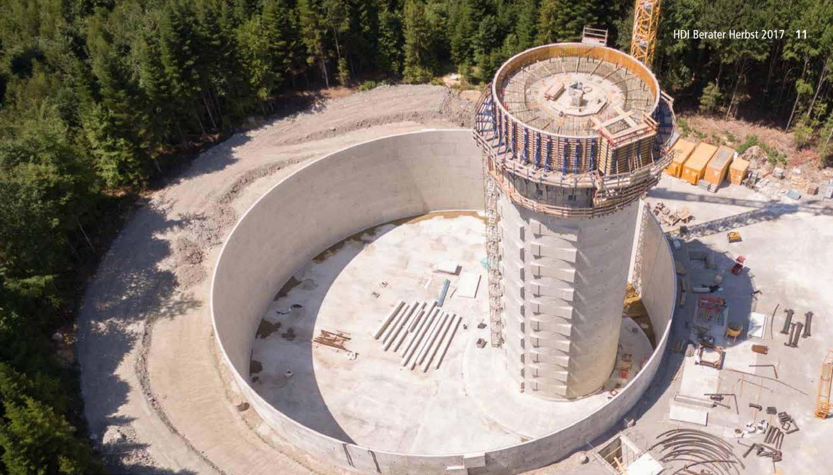
Im Inneren des Turmfußes befindet sich das „Aktivbecken“, außen herum entsteht deutlich erkennbar das größere „Passivbecken“
